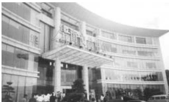
写真 - 1 華南（国際）物流鋼鉄購買センター
